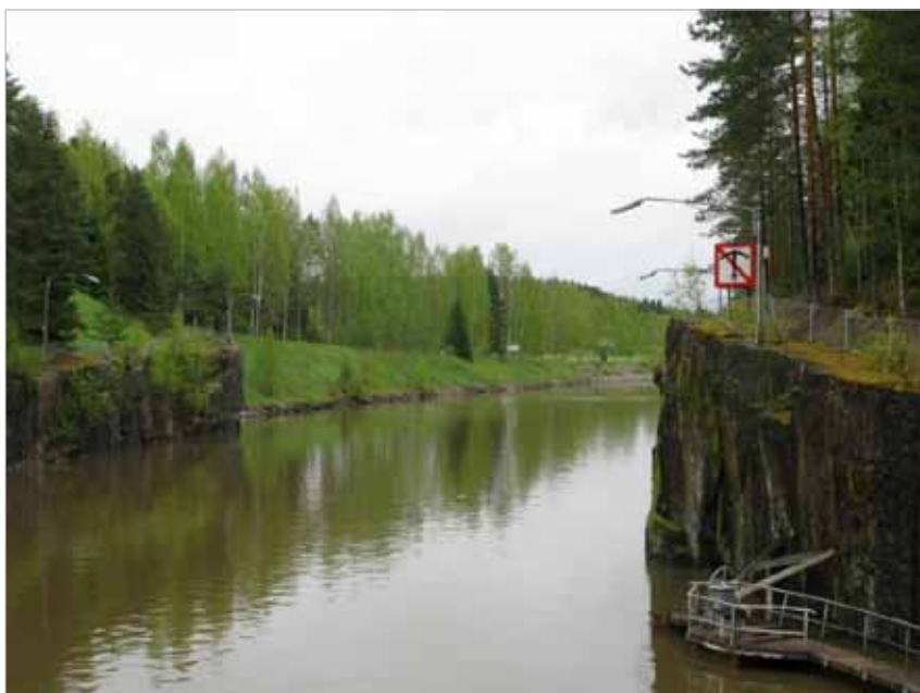
Uuden kanavan alkupäätä Nuijamaan kohdalla. Kuva: Janne Nokki
