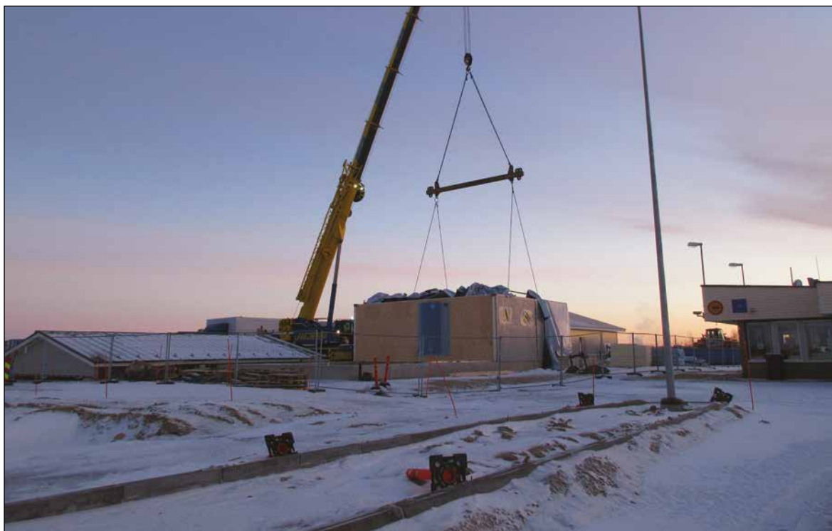
Elementtejä pystytetään työmaalla marraskuussa 2018. Heikki Lauhamaa
